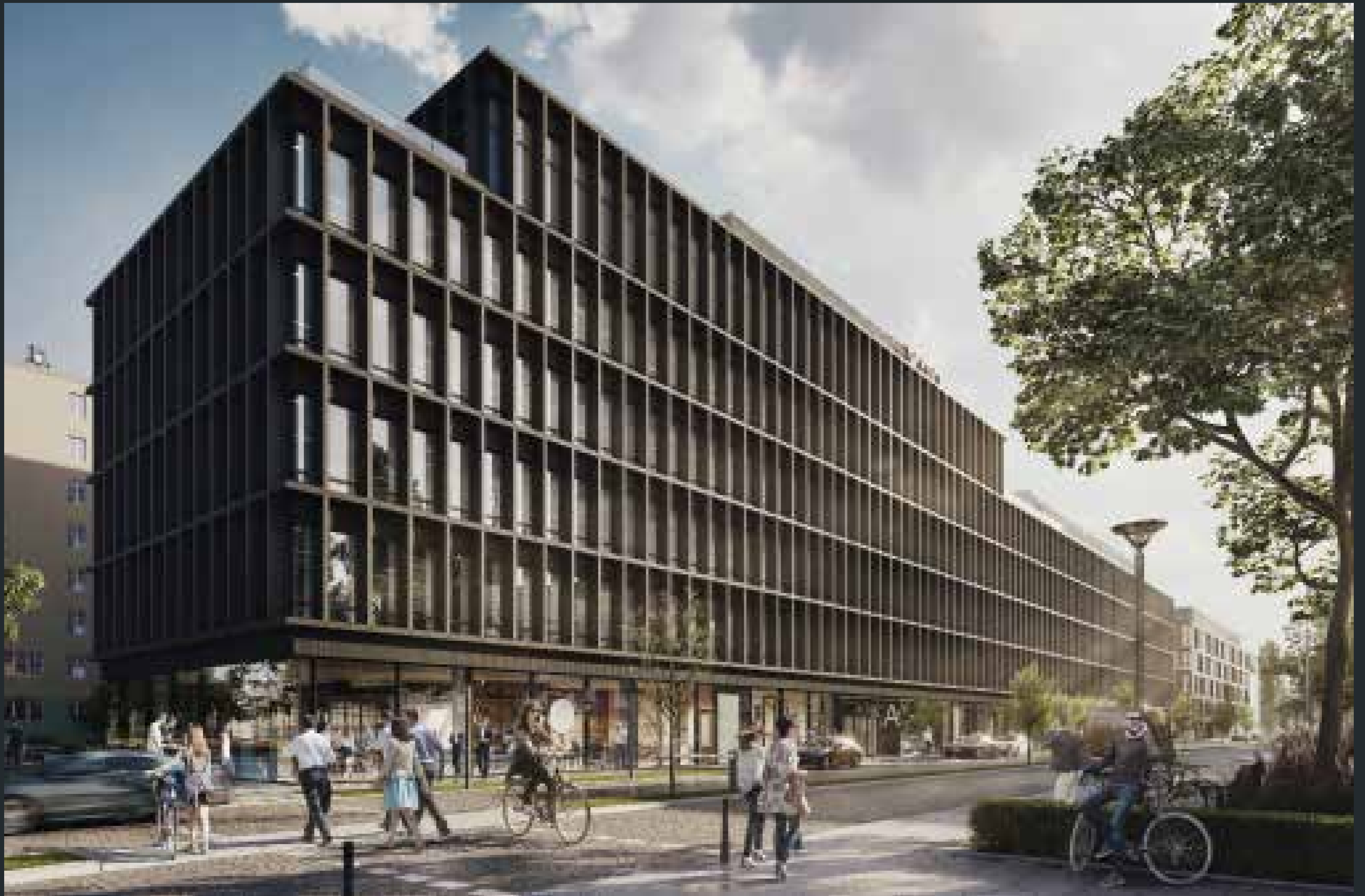
Widok głównej fasady X20 od ulicy Czerniakowskiej | X20 main facade view from Czerniakowska St.
